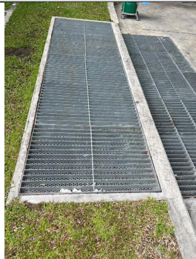
รูปที่ 2-8 การดูแลระบบระบายน้ำให้สะอาด ไม่มีตะกอนอุดตัน
