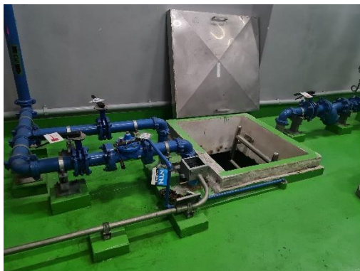
รูปที่ 2-7 การดูแลระบบท่อประปา และการล้างถังเก็บน้ำ
